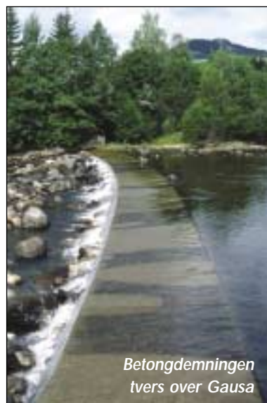
Store steinmasser nedenfor demningen i Harpefossen
